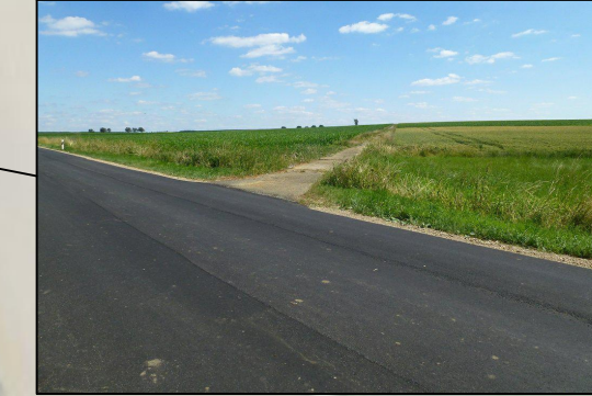
Blick in die Tiefenlinie am Annahof
