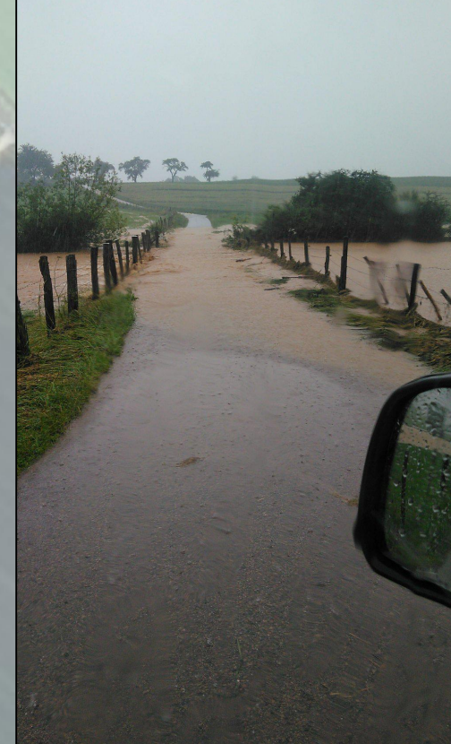
Querbauwerk am Langebach zum Hochwasserereignis
