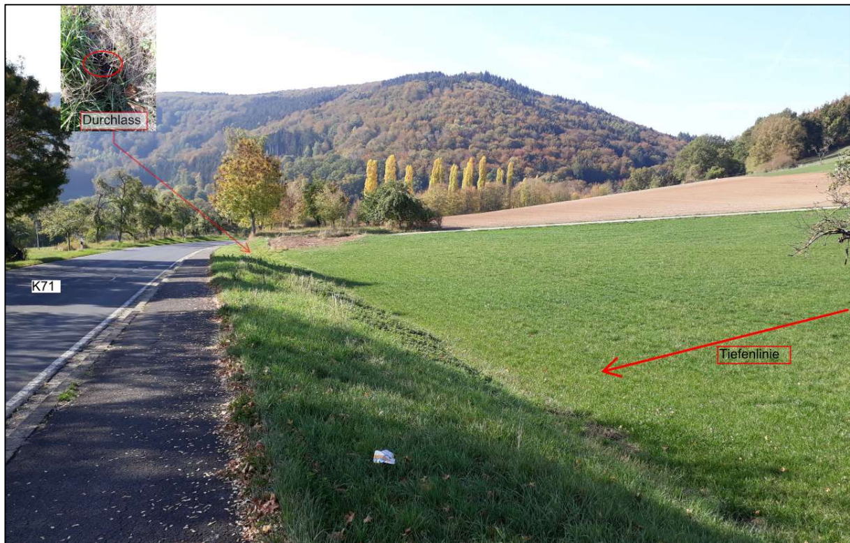
Abbildung 31: natürlicher Retentionsraum durch K71 in Dammlage
