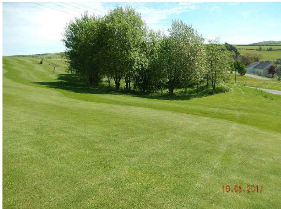
Mulde III von Mulde II aus gesehen / Differenz OK Wall – Sohle ca. 1,80m
